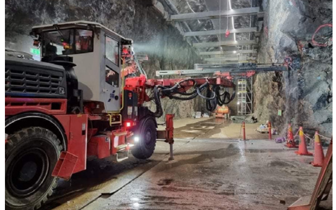
Gnesta Bergbyggare utför arbete inne i Henriksdals reningsverk.
